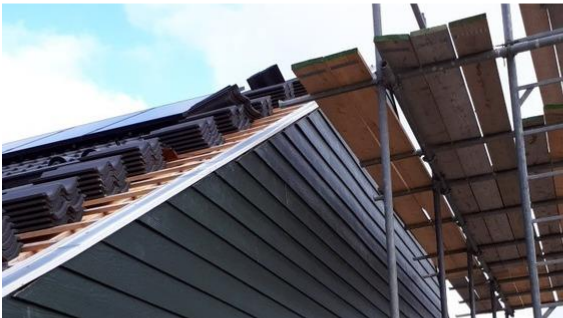
Detailfoto dak en gevelafwerking
