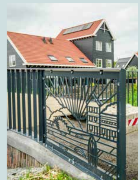
Brug op de Nobellaan t.h.v. De Houtzagerij
